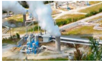
在地可再生能源发电影响测量 印度尼西亚Wae Sano地热发电厂
