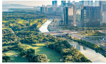
城市河流修复与防洪管理 中国深圳大沙河生态长廊
