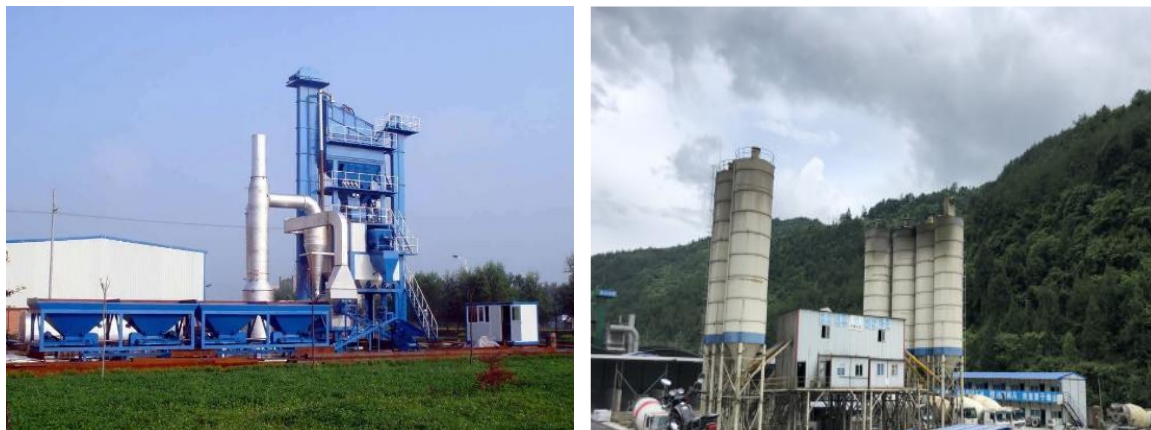
图 10. 粉尘及有害气体的防治措施：沥青拌和站油改气
