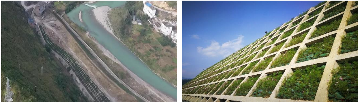
图 12. 3#弃土场台阶型斜坡滩涂地改造为平地
