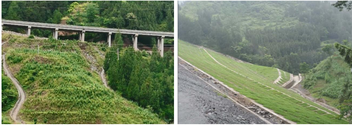
图 7. 本项目对弃渣场的生态修复工程
